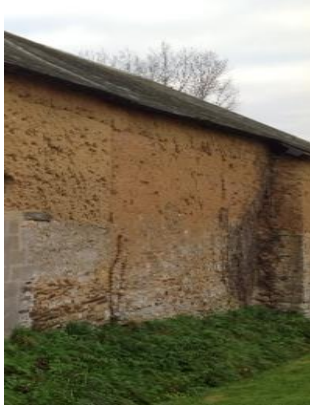
Mur en terre crue au Molay-Littry
