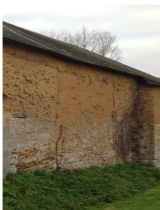
Mur en terre crue au Molay-Littry
