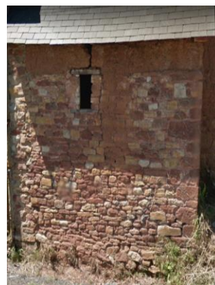
Mur en poudingue pourpré à Cartigny-l'Épinay
